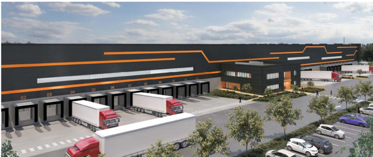
Façades de quais et zone de bureaux
